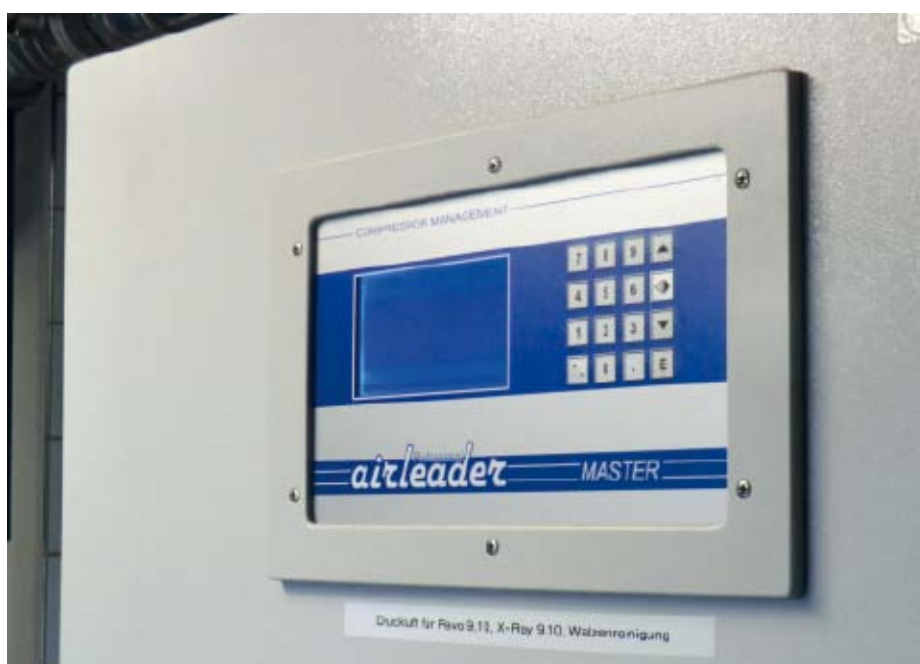
■ Abb. 2: Die Speicherkapazität des Airleaders Master genügt für eine detaillierte Zustandshistorie mit Statistikdaten über einen Zeitraum von mehr als sechs Jahren Produktionszeit.
